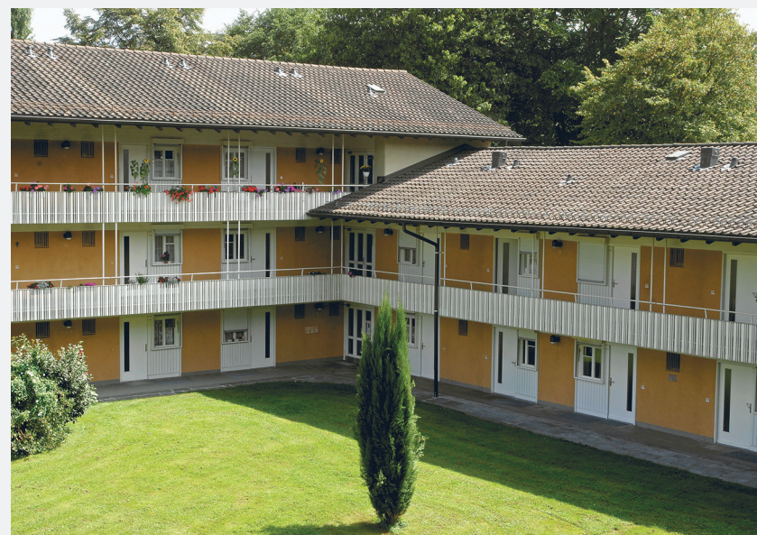
Liebenswerte Idylle unter Denkmalschutz: Die SAW-Gründungssiedlung Espenhof
