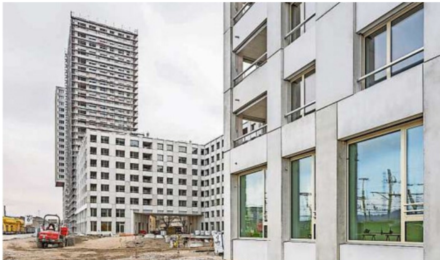
Blick in den Letzi-Siedlungshof am Gleisfeld. Bild: Tom Licht
